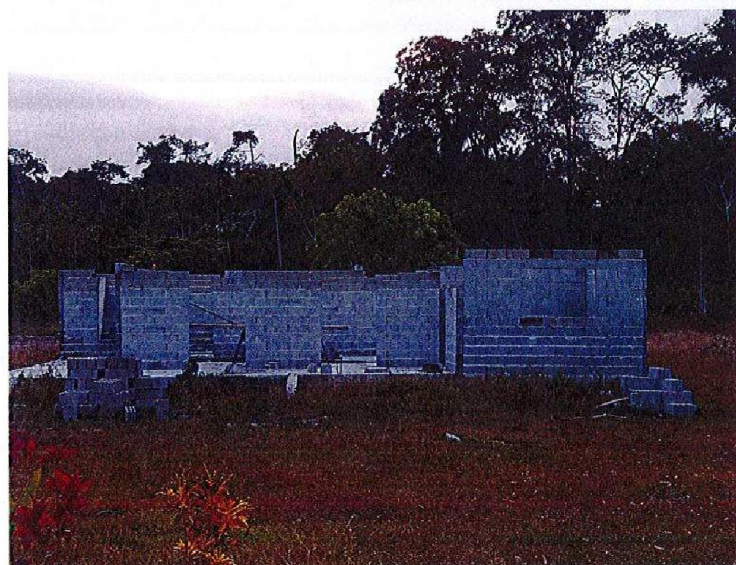
Nouvelle construction du couple MAIGNAN jouxtant leur habitation actuelle.
